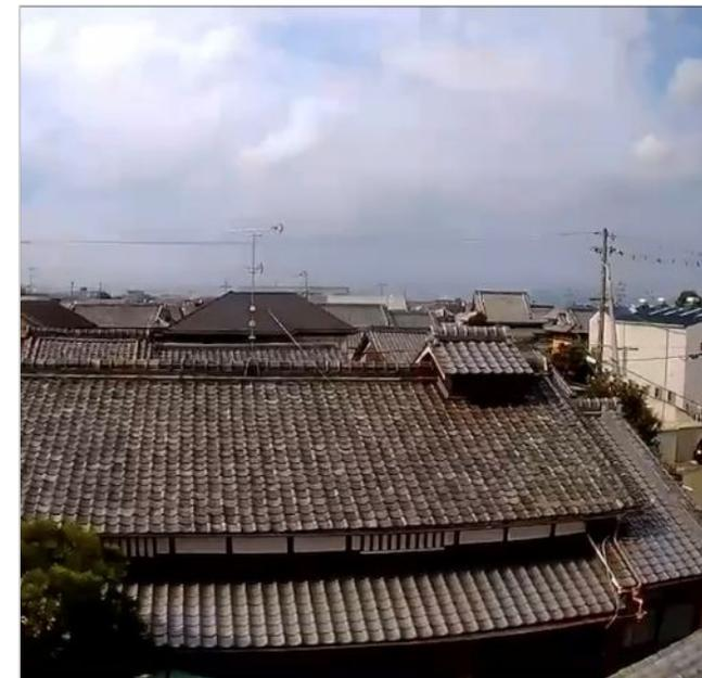
腰屋根という技法を用いて建設されています。腰屋根とは、屋根の上にもう一つ小さな屋根を設ける方法で、腰屋根の部分では、光を取り入れる他に蚕を育てるなどに使われていました。
