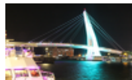
淡水フィッシャーマン 美しい斜張橋
