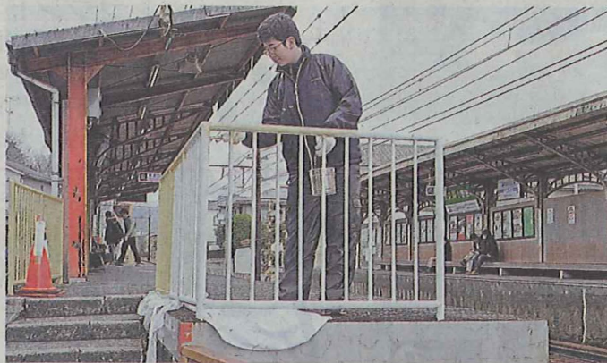
塗装がはげた手すりをペンキで塗り替える生徒 (京都市左京区・八幡前駅)
